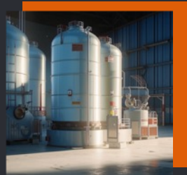
Объекты хранения аммиака
